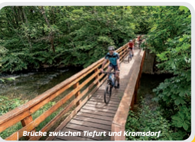
Brücke zwischen Tiefurt und Krämsdorf
